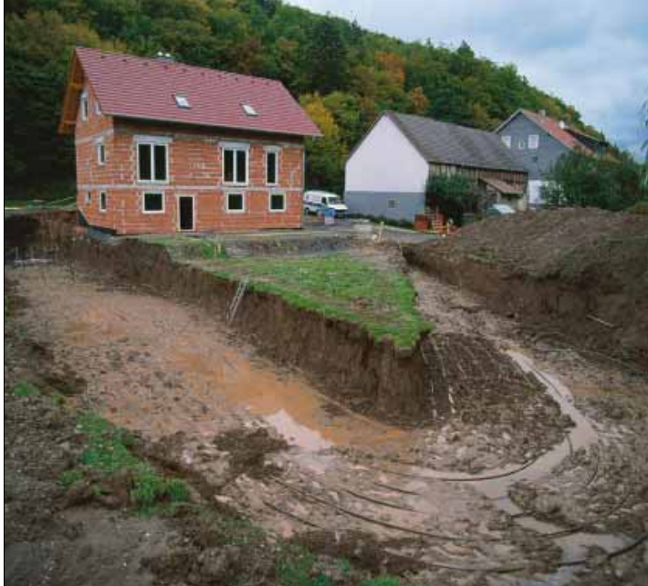
Bij een warmtepompsysteem wordt de warmte via een aardwarmtewisselaar uit de bodem gehaald
