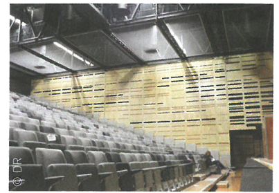
De Commanderie van Dole, waar verplaatsbare akoestische wanden met rails aan de vloer en met een structuur aan het plafond bevestigd zijn.
